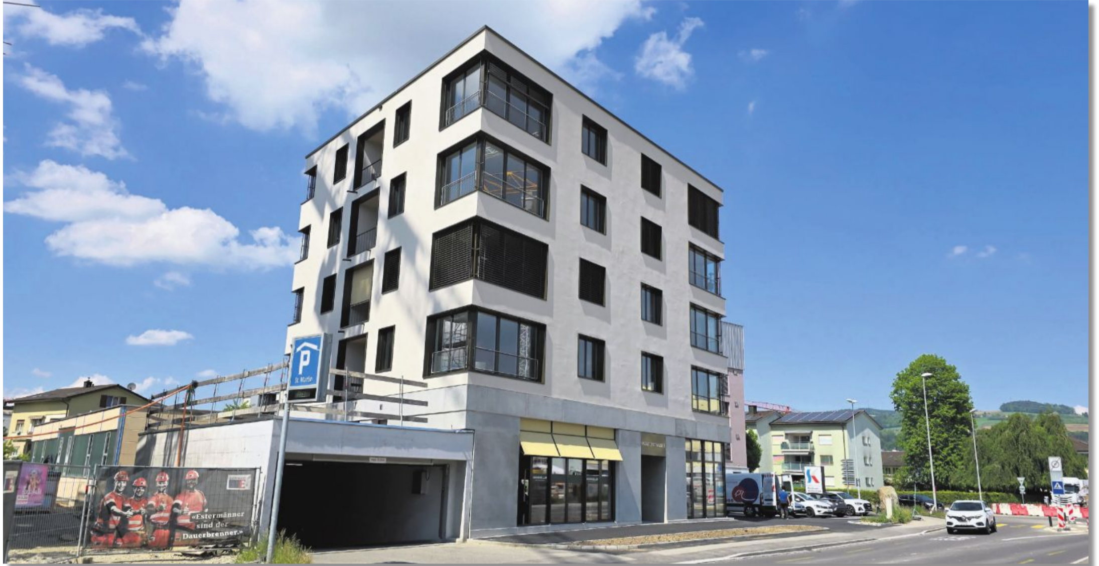
Aussenansicht des Neubaus an der Münsterstrasse 9b, Sursee. Fotos CBU
